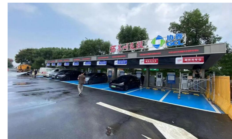
▲ 江苏高速公路光储充一体化超级充电站
